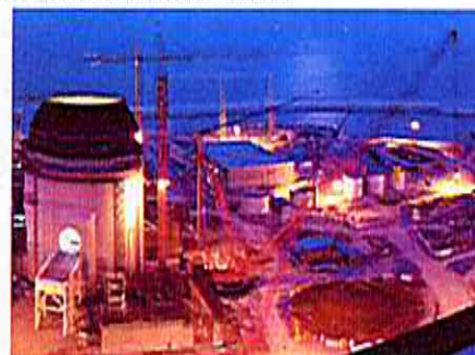
2.4.4.5-2. ábra: A Shin-Kori erőmű építési munkái
