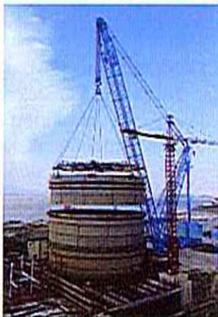
2.4.4.1-1. ábra: A harmadik konténment gyűrű beemelése Sanmen 1. telephelyen
