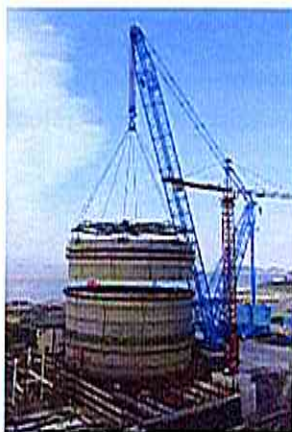
16. ÁBRA: A HARMADIK KONTÉNMENT GYŰRŰ BEEMELÉSE SANMEN 1. TELEPHELYEN
