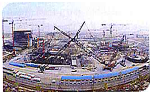
20. ÁBRA: TAISHAN 1-2. ÉPÍTÉSI MUNKÁI
