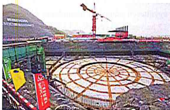
17. ÁBRA: HAIYANG 2. ÉPÍTÉSE
