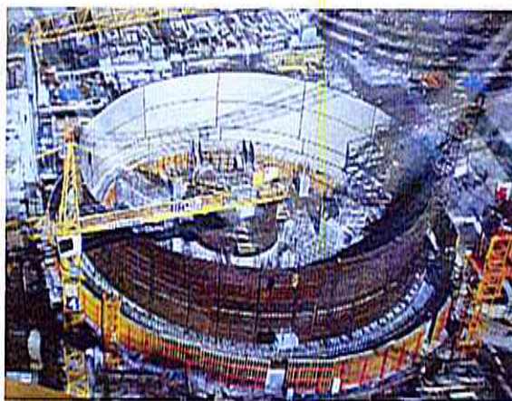
18. ábra: Az épülő erőművi blokk Szosznovij Borban
